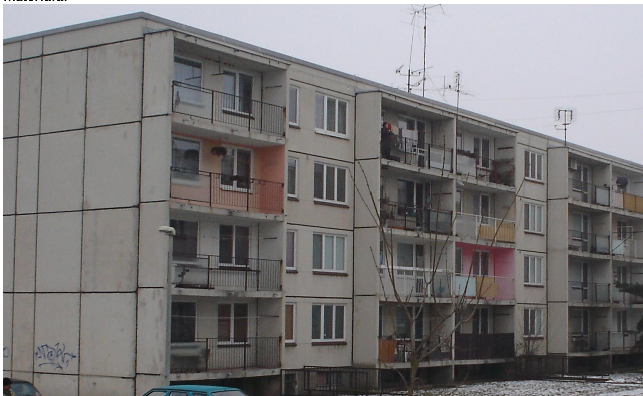
Foto domu – čp. 590 je mimo snímek
