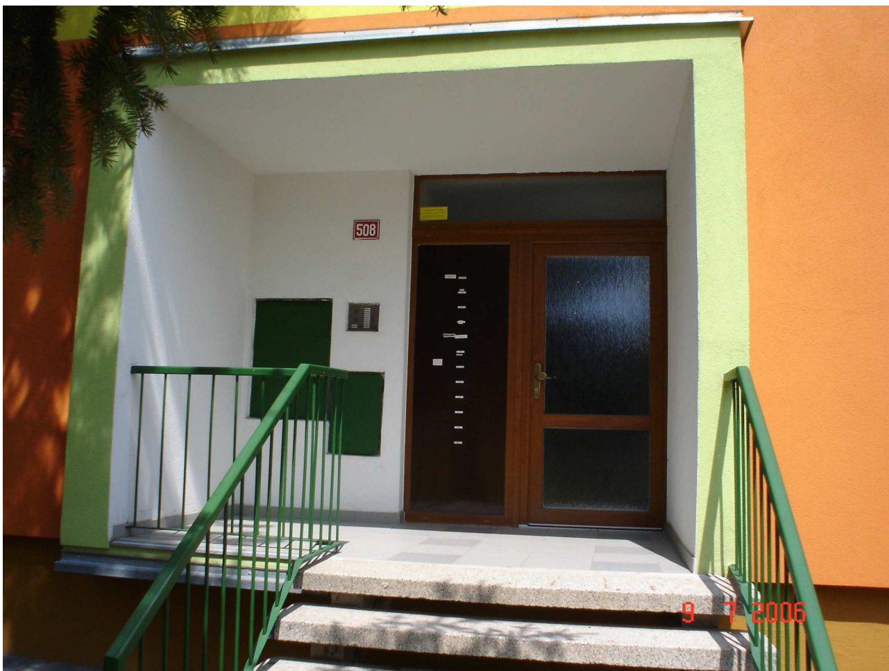
detail vchodu čp.508,
