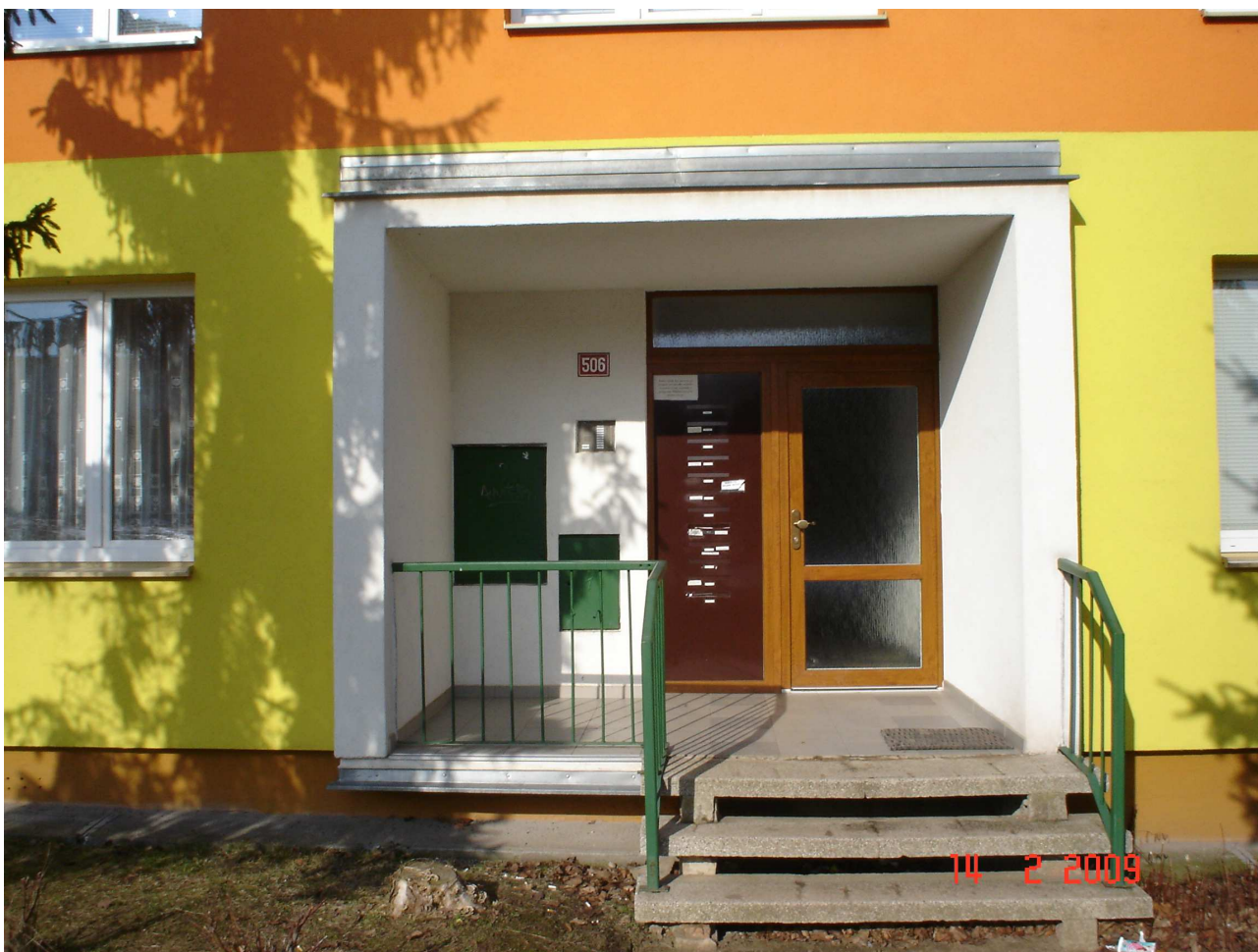
detail vchodu čp.506,
